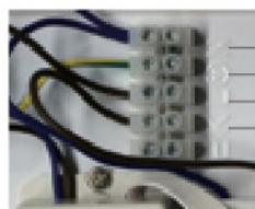
消防应急吸顶灯接线方式
